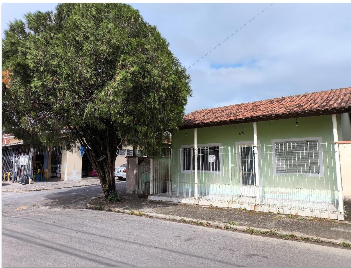
Figura 4 - Fachada do imóvel em questão.
