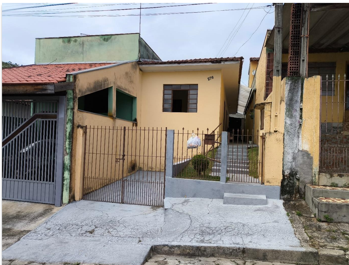
Figura 3 - Fachada do imóvel em questão.
