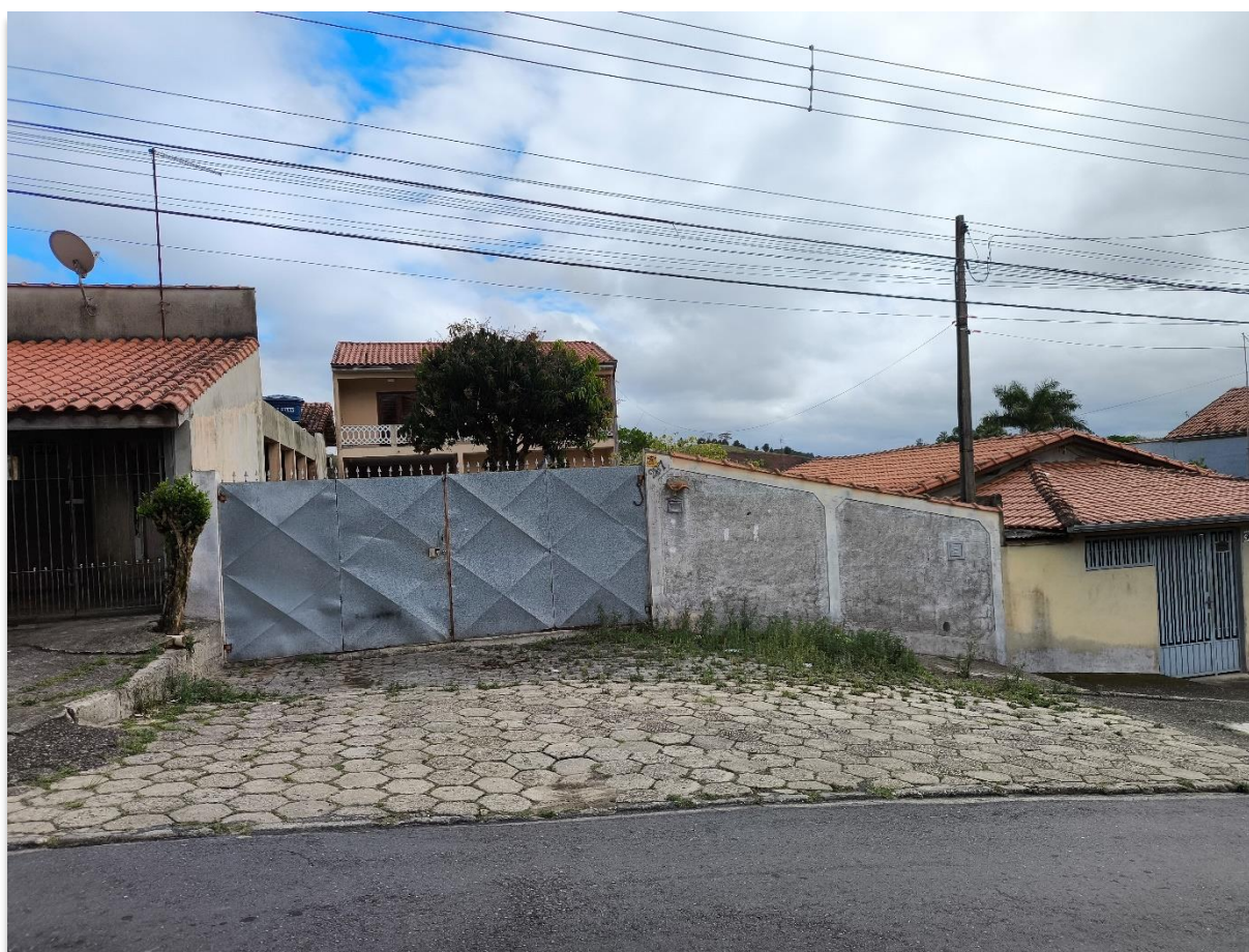
Figura 5 - Fachada do imóvel em questão.
